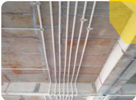
Surface/Slab Conduiting
